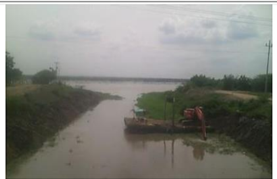
COMENTARIOS: Se aprecia Retroexcavadora Hitachi 200, montada en el bote en la actividad de Dragado y Retiro de maleza acuática en el Caño Renegado
