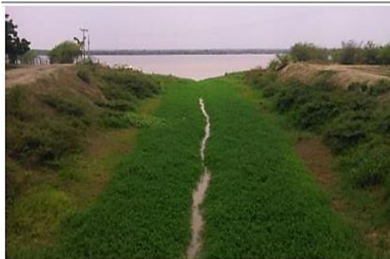
COMENTARIOS: Panorámica del Caño Renegado antes de intervención
